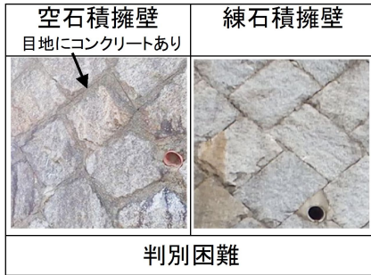
図-3 空石積擁壁と練石積擁壁の外観
