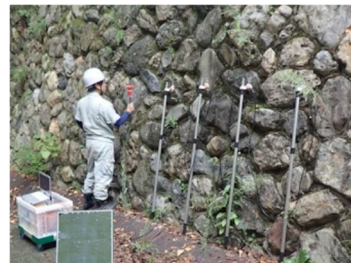
写真-3 擁壁の表面波探査状況
